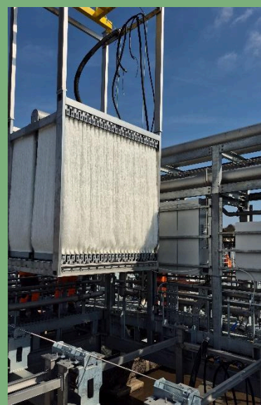
Rysunek 1 – Kaseta ZeeLung podczas instalacji w zbiorniku anoksycznym
